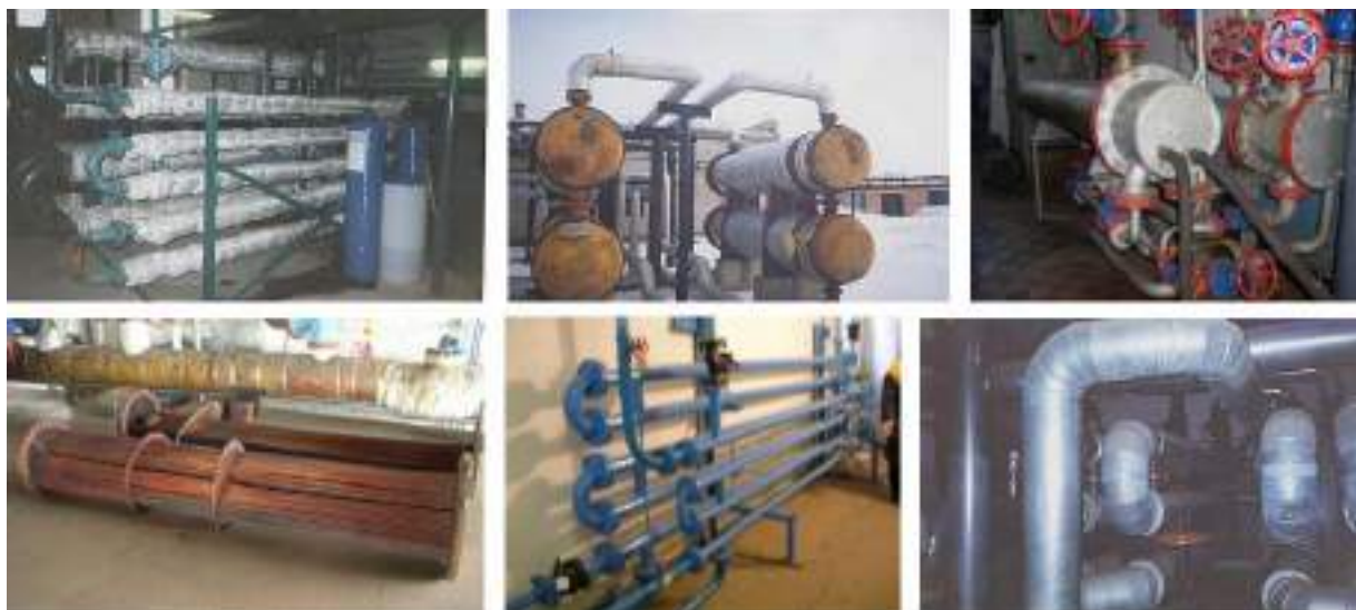
1.4-rasm. Maishiy energetikadagi qoplama quvurli IAQlari.
