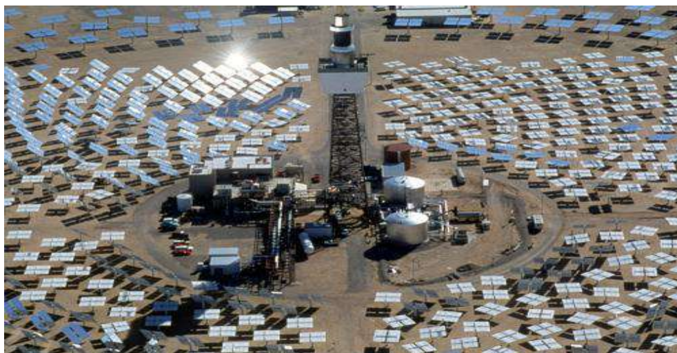
1-rasm. Quyosh elektr stansiyasi
