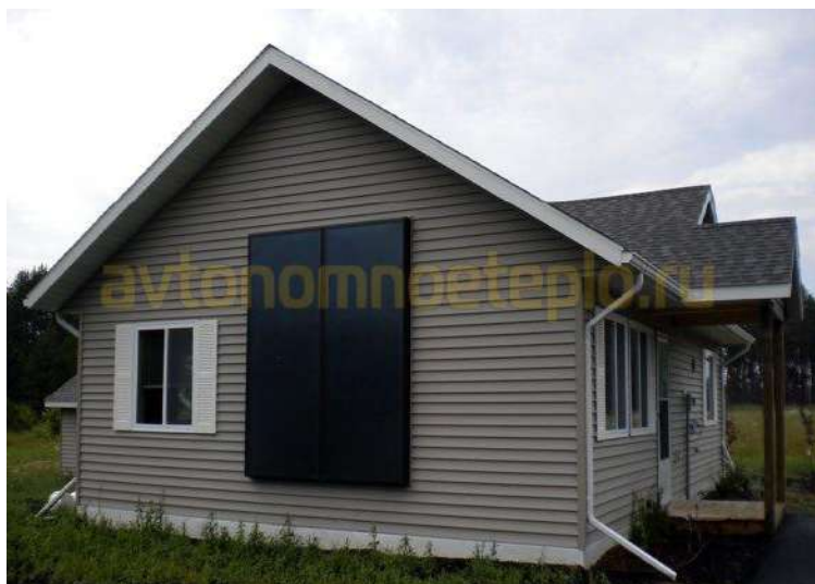
1-rasm. Havo kollektori uy dvoriga o'rnatish
