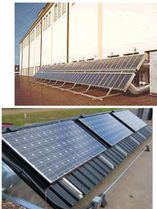
5-rasmlar. SolarWall kompaniyasi tomonidan yaratilgan havo fotoissiqlik qurilmalari
