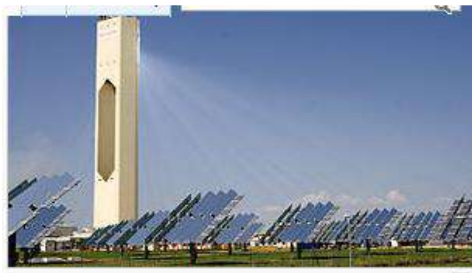
2-rasm. Minora tipidagi quyosh elektr stansiyasi
