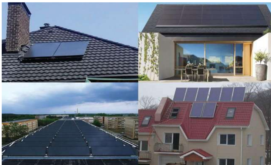
5-rasm. Yassi quyosh kollektorlarining ayrim dizaynlari va ularni binolarning tomlariga joylashtirish variantlari.
