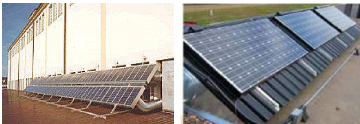
75,76-rasm. SolarWall kompaniyasi tomonidan yaratilgan havo fotoissiqlik qurilmalari
