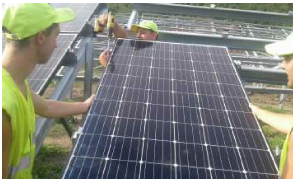
65-rasm. Quyosh fotoelektrik stansiyasida quyosh panellarini muxandislar tomonidan o‘rnatish
