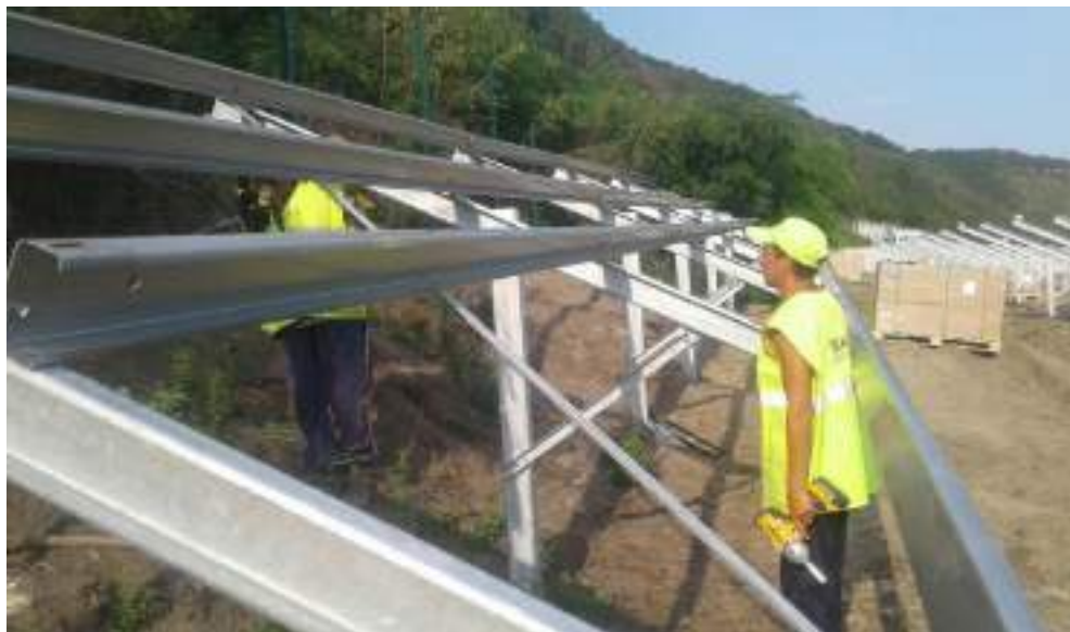
64-rasm. Quyosh fotoelektrik stansiyasining karkas qismini o‘rnatish
