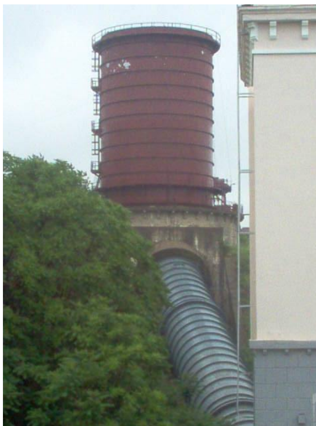
2 – расм. Окқовоқ ГЭСи тенглаштиргич резервуари.
