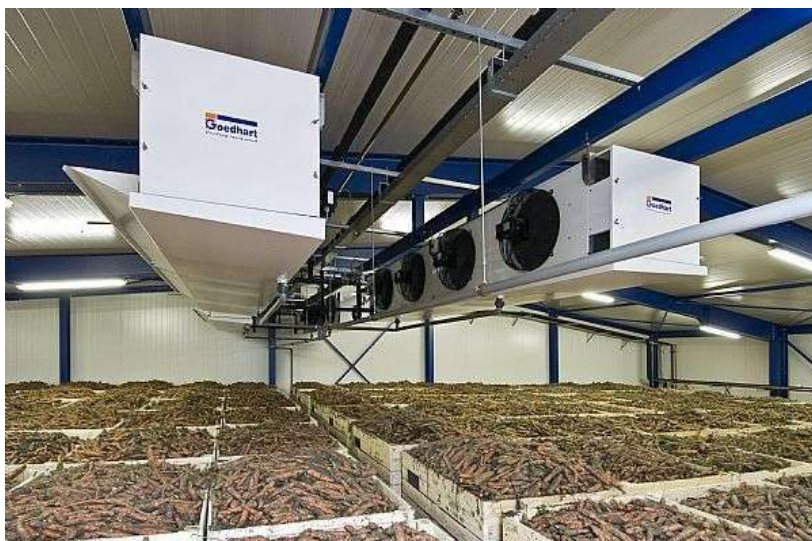
7-rasm. Zamonaviy tipdagi sovutish va shamollatish tizimlari bilan jihozlangan meva-sabzavot omborining ichki koʻrinishi
